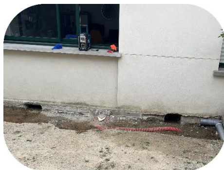
SDS : décaissement et carottage des deux points d'extraction sous dallage
