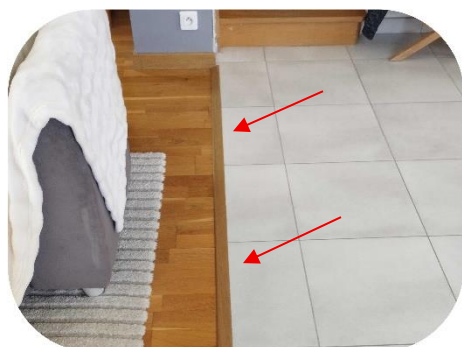
Jonction des dallages séjour (maison) et salon (extension)
