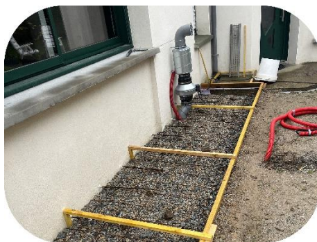
SDS : installation terminée, en attente de la dalle de finition
